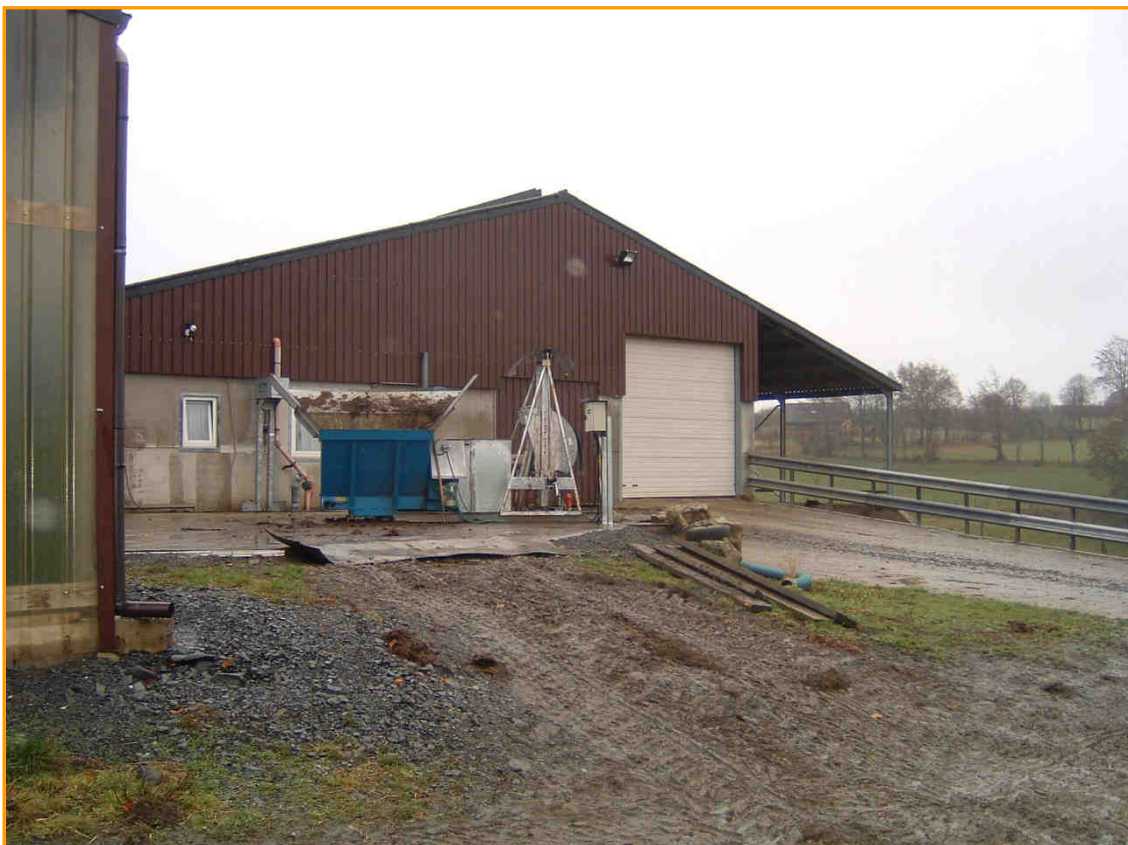
Installation de biométhanisation Heck entre 2003 et 2008
